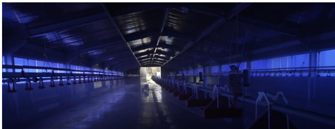
Bâtiment de 400 m 2 , avec capacité de 4000 volailles.
