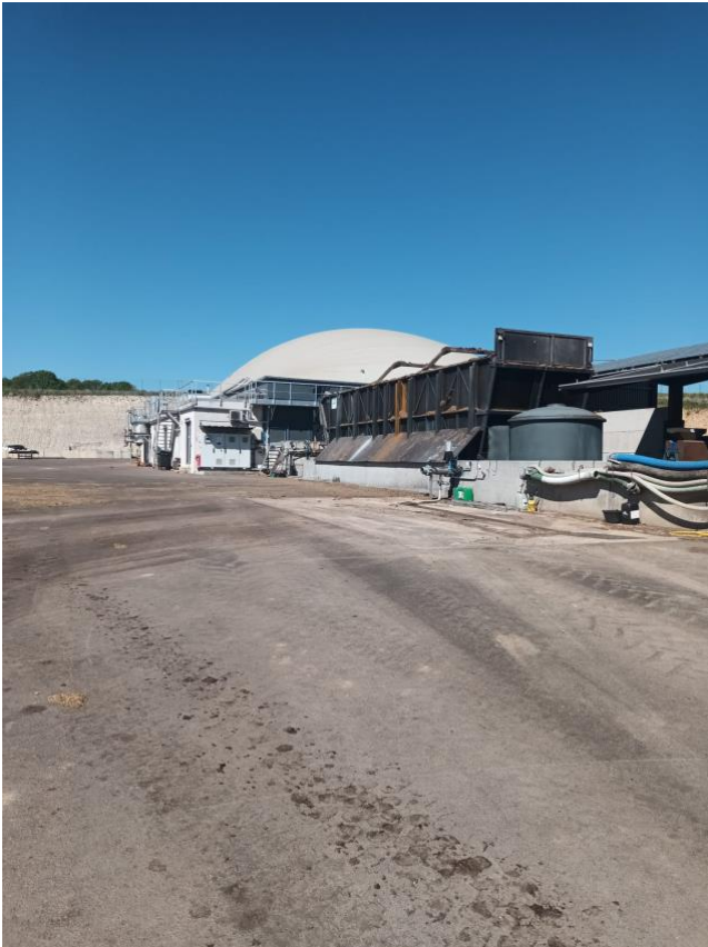
Unité de méthanisation en voie solide de la SAS Terres Energie, Pont-sur-Vanne (89)
