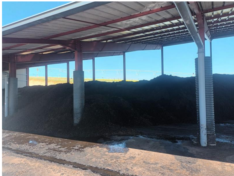
Stockage de digestat solide sur l'unité de méthanisation
