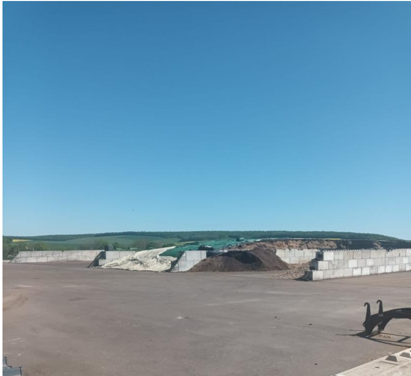
Silos de stockages sur le site de méthanisation de la SAS Terres Energie
