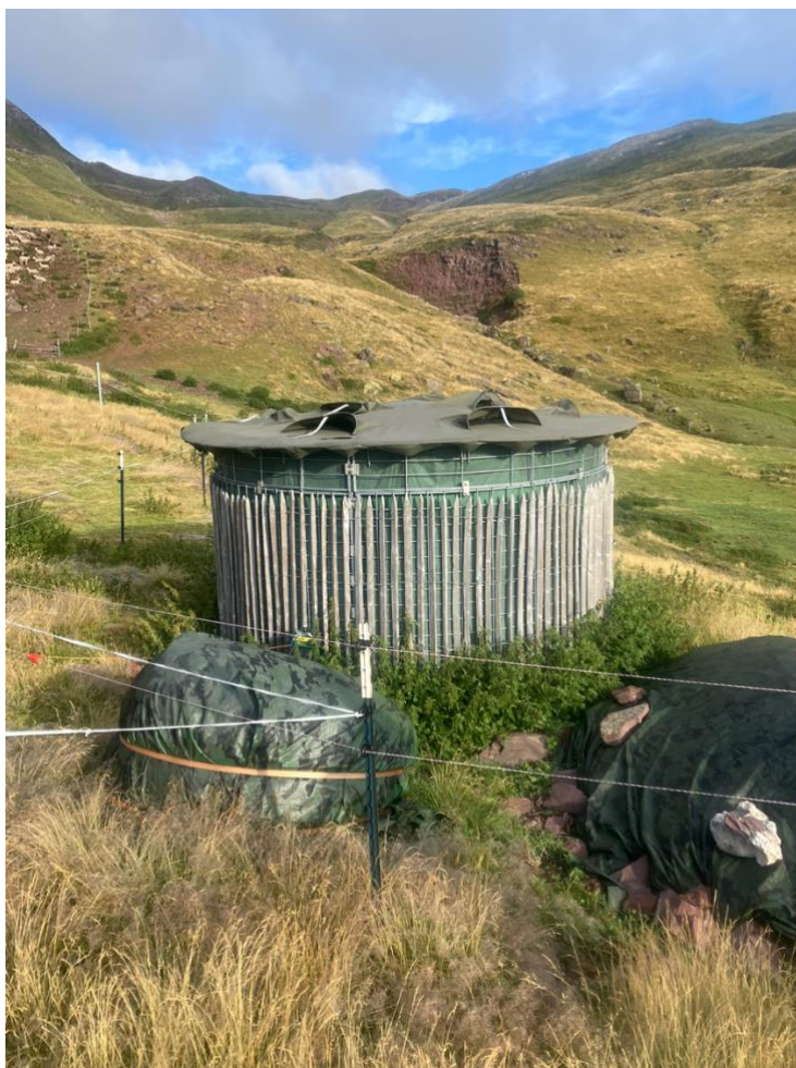
Figure 7 - Dispositif d'épuration du petit lait – Cabane de Lurbe, Plateau de Banasse
