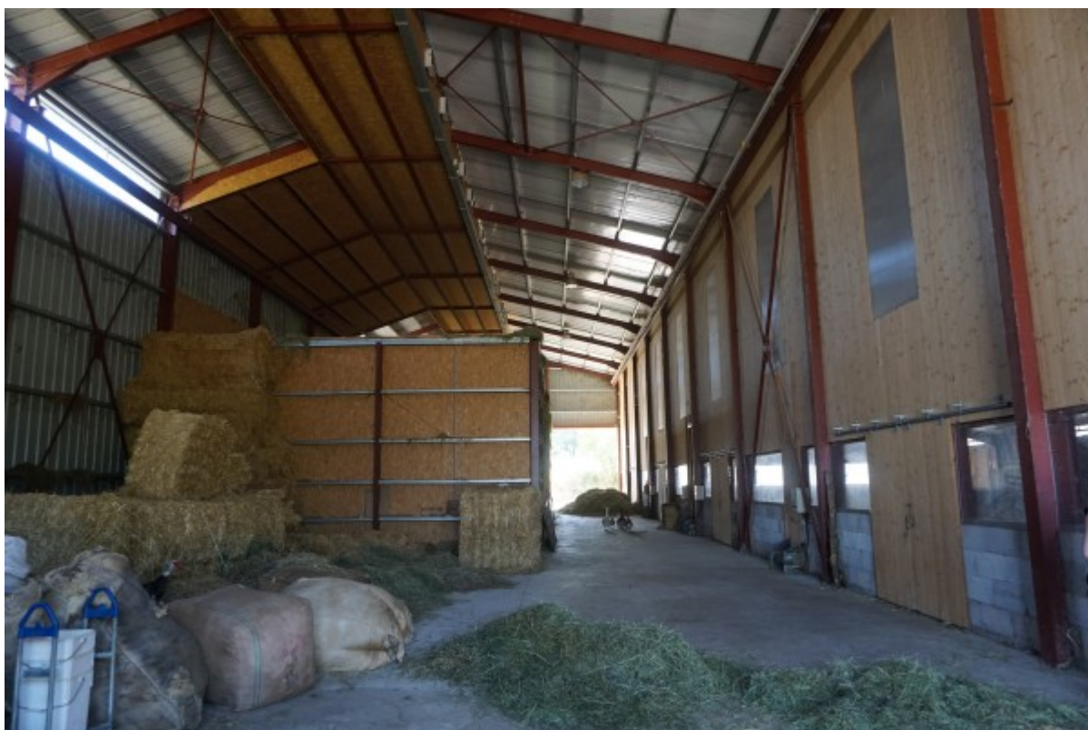
Intérieur du bâtiment. Photo C. Milou / Solagro
