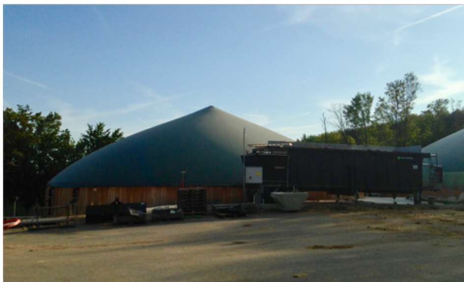
Digesteur sur le site du GAEC des Charmes
