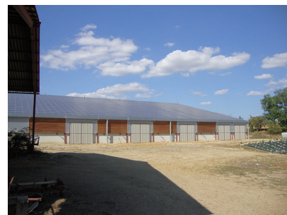
1300 m2 de panneaux photovoltaïque sont orientés plein sud
