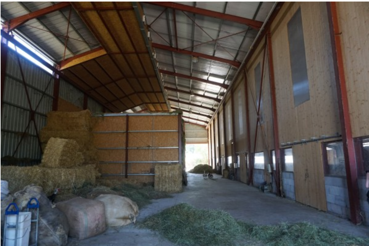
Intérieur du bâtiment. Photo C. Milou / Solagro
