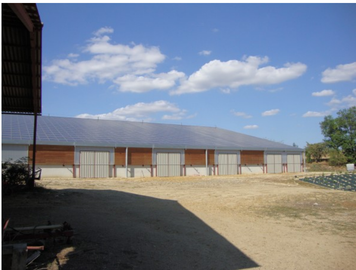
Le nouveau bâtiment et sa toiture de panneaux photovoltaïques. Photo JL. Bochu / Solagro
