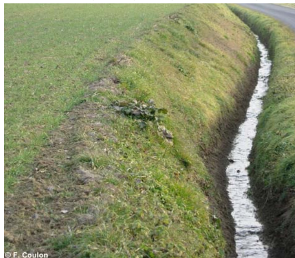
Fossé collectant l'eau de ruissellement.
